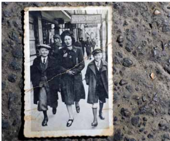
Fotografie recuperată din clădirea din Piața H. Botescu, nr. 18
